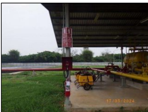
รูปที่ 2-24 ระบบป้องกันภัยและระงับอัคคีภัยบริเวณถังน้ำมันและพื้นที่คลังน้ำมัน
