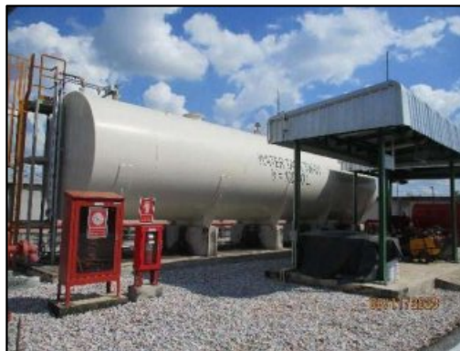
รูปที่ 2-25 ระบบป้องกันภัยและระงับอัคคีภัยบริเวณสถานีเพิ่มแรงดัน
